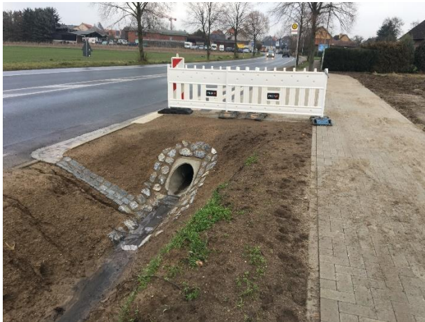
Bild 1: Bushaltestelle Sickte im Bau
