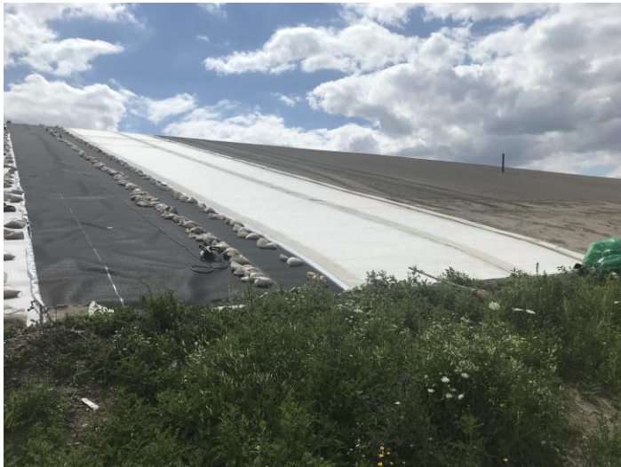
Bild 1: Abdichtung im Bau
