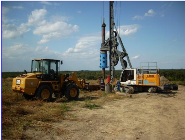
Bild 1: Deponiegasbrunnen im Bau
