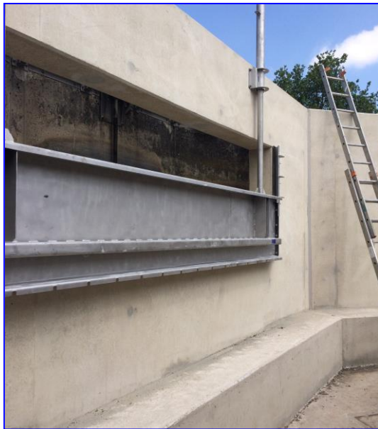
Bild 1: Einbau neuer Ablaufschächte und -wehre
