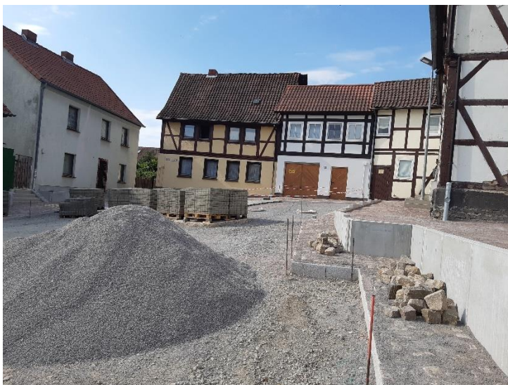
Bild 1: Luseberg in Schöningen im der Umbauphase
