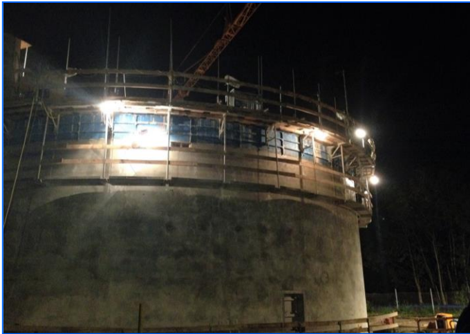
Bild 1: Betonieren mit Gleitschalung
