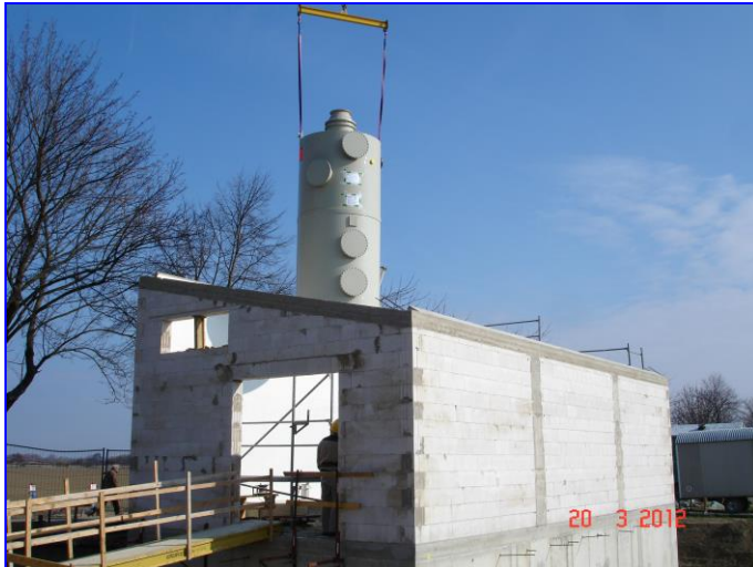
Bild 1: Einbringung Riesler in den Rohbau
